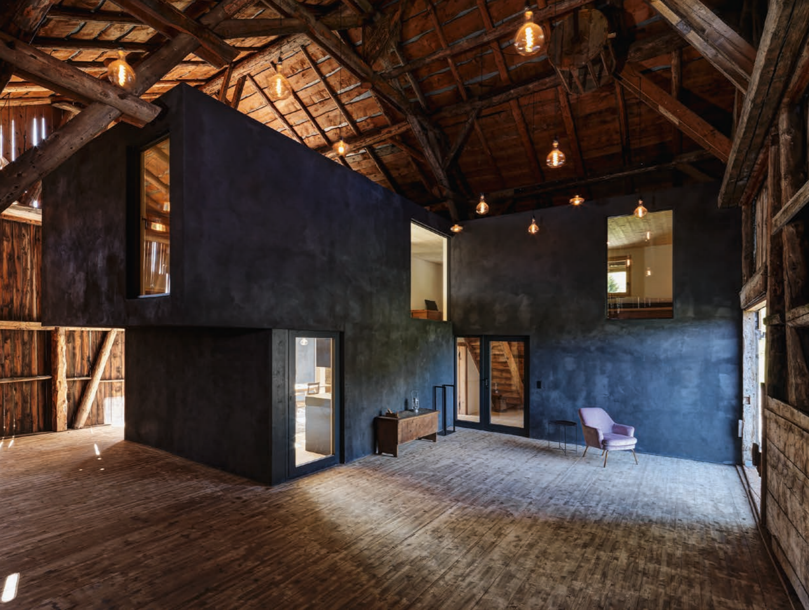
Der in die Scheune eingefügte Holzbau wurde isoliert und wird im Winter mit dem Specksteinofen im Wohnzimmer beheizt.
