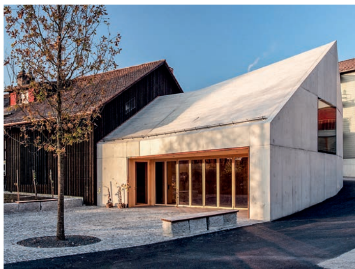
Das Haus des Weins schliesst an den originalgetreu rekonstruierten Wirtschaftsteil an (l.).
