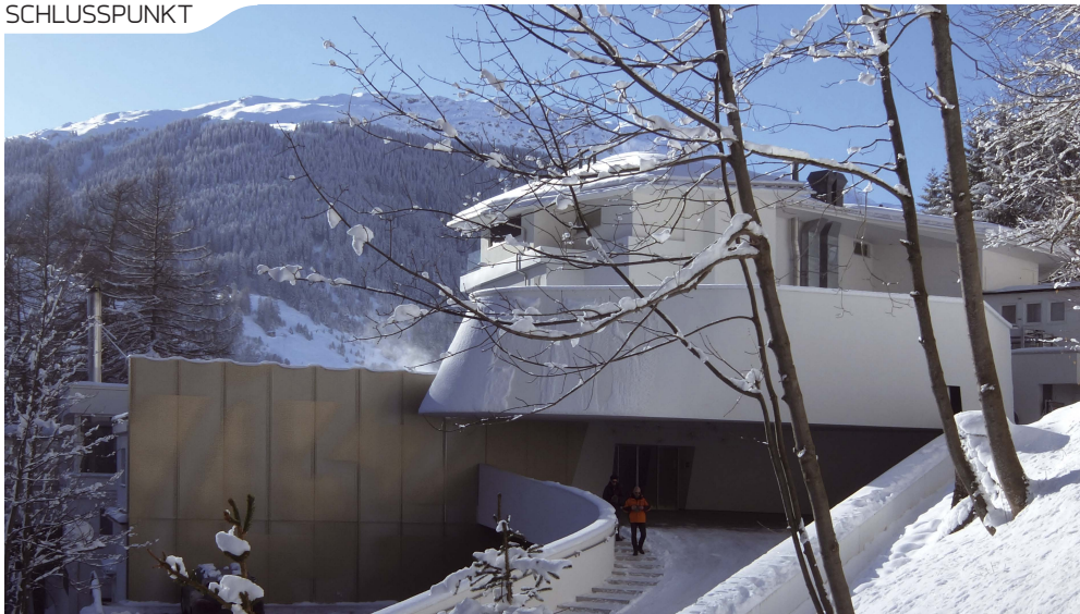
Die bescheidene Eingangssituation an der Rückfassade des Gebäudes entspricht nicht einem 5-Sterne Hotel.
