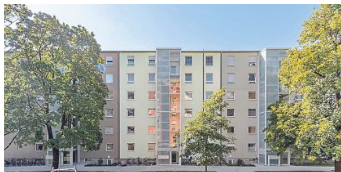
Nachher: das Haus der Genossenschaft – um zwei Etagen erhöht und mit Außenaufzügen. 12 neue Wohnungen sind entstanden. F: Lothar Reichel
